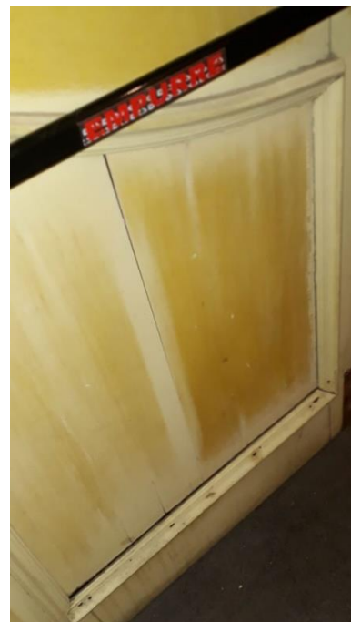
Imagem 27: Conservação da pintura e descolamento de peças de madeira da Porta 2
