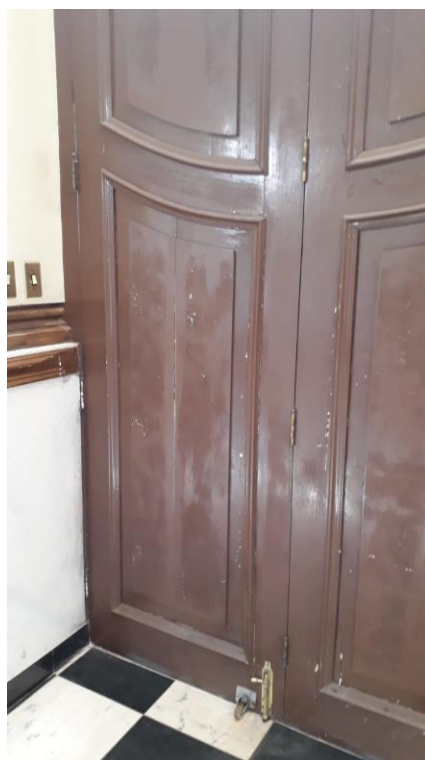
Imagem 7: Trincas e Detalhes da Pintura da Porta 3.
