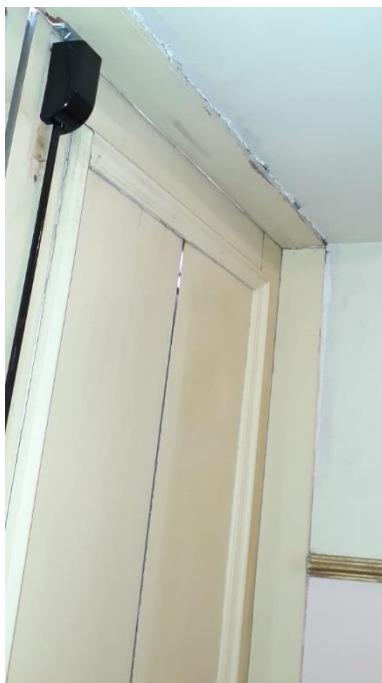
Imagem 26: Espaçamento e Junta entre alvenaria e a porta 2
