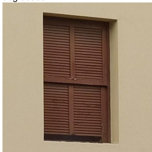
Imagem 37: Parte da moldura da Janela 5 faltando
