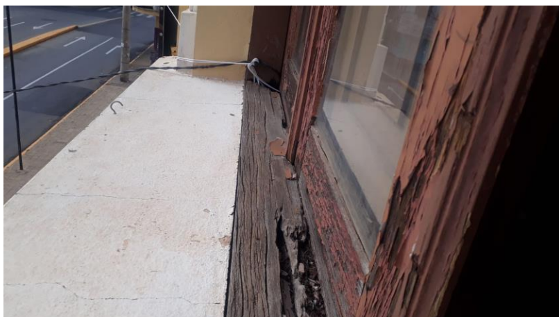
Imagem 60: Detalhe do Peitoril e da Contraverga da Janela 5.
