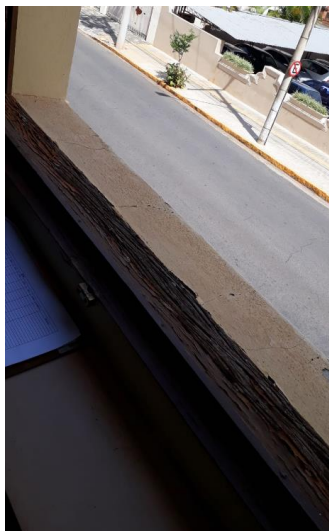
Imagem 47: Detalhe do desgaste da moldura.
