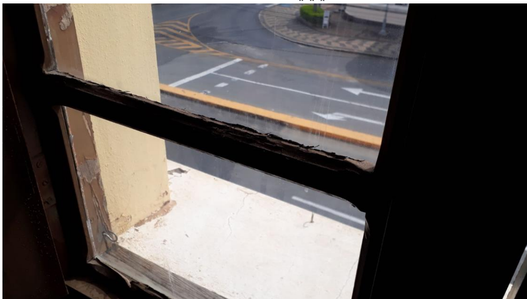
Imagem 55: Detalhe da pintura descascando da Janela 2.
