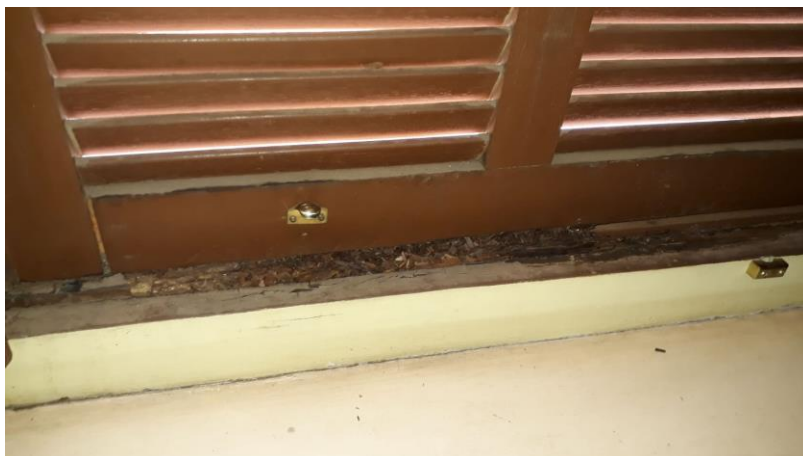
Imagem 45: Detalhe do desgaste da moldura na janela 3
