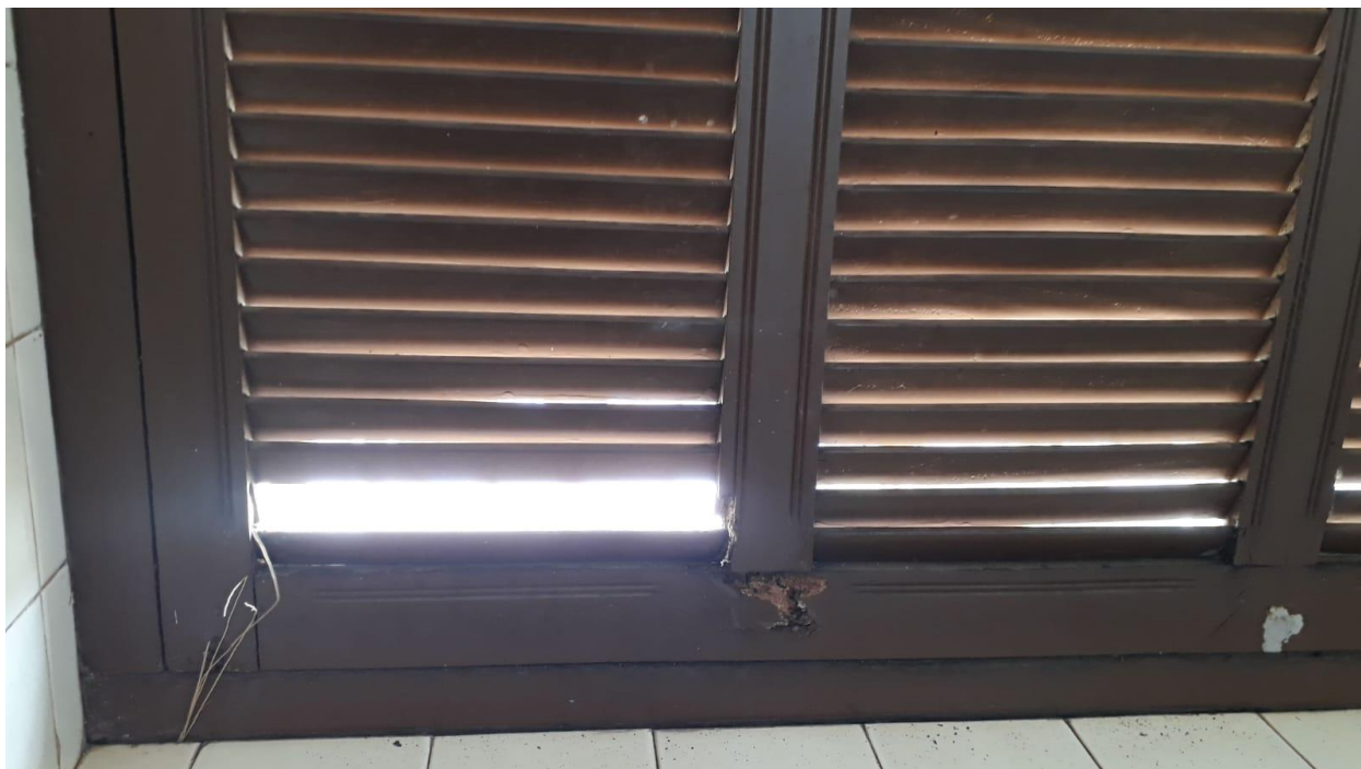
Imagem 68: Detalhe do desgaste e da falta da ripa na janela do banheiro feminino no 2º Piso
