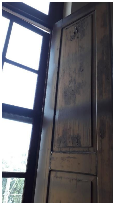
Imagem 63: Detalhe da pintura e da guilhotina empenada
