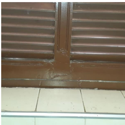
Imagem 17: Detalhe do reparo provisório feito na Janela 1
