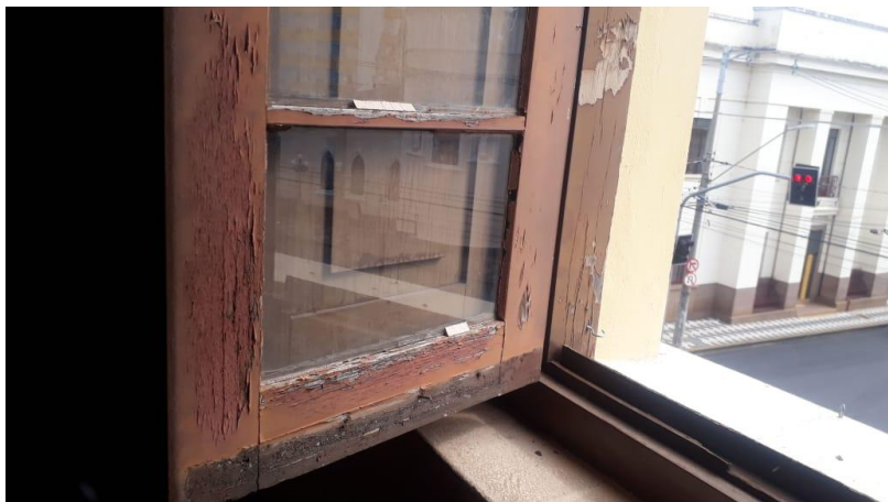
Imagem 59: Detalhes da Pintura Externa da Janela 5 e falta de massa.
