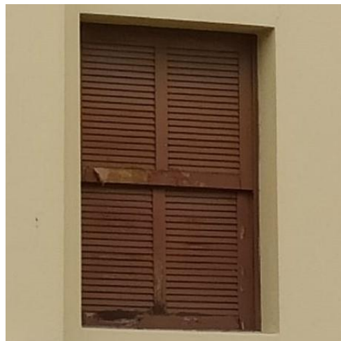
Imagem 36: Janela 4 – Parte da moldura degradada
