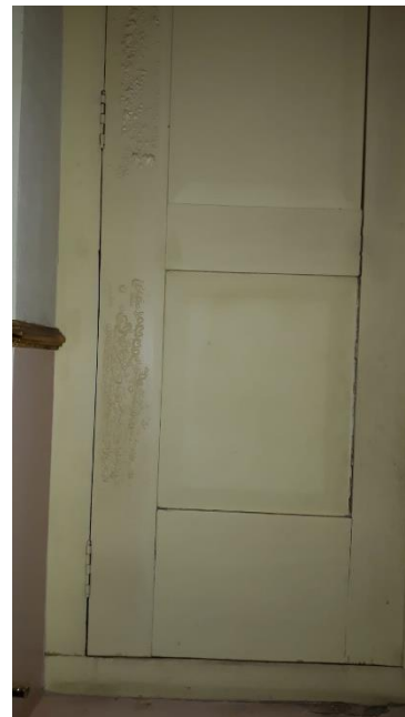
Imagem 77: Bolhas na pintura da janela 6 do 2º Piso
