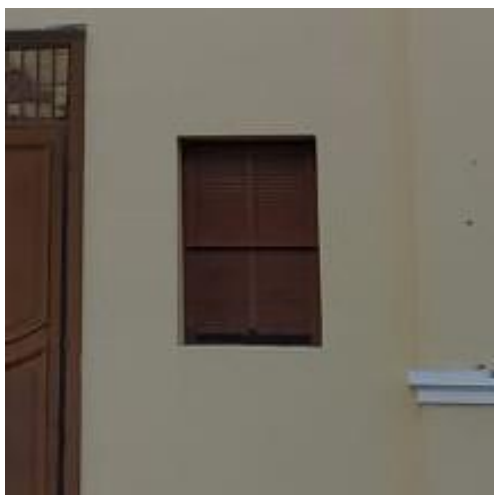
Imagem 35: Janela 3 – Parte da moldura faltando
