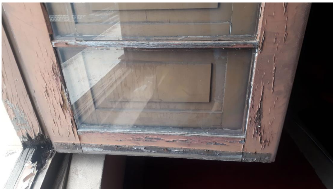
Imagem 56: Pintura externa, vidros sem emassamento e desgaste da moldura da Janela 3.
