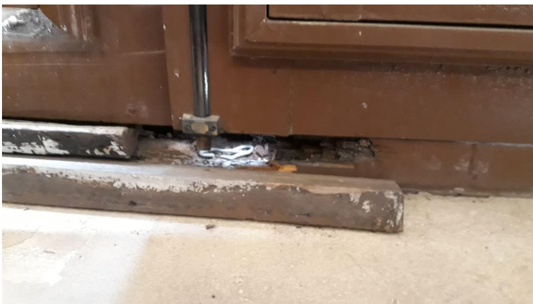
Imagem 54: Desgaste da Contraverga da Janela 2
